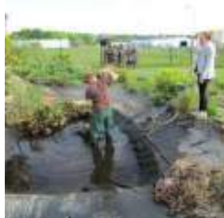
Gauthier en train de vider le bassin (travaux à venir)
